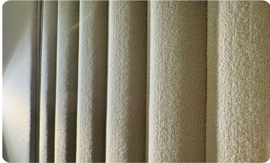
內飾面選用高級內裝絨布 吸音採用聲學擴散 + 吸音棉加乘材料設計
